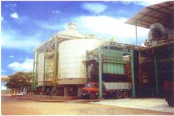
Foto 7: Vista de área de decantação e filtragem
